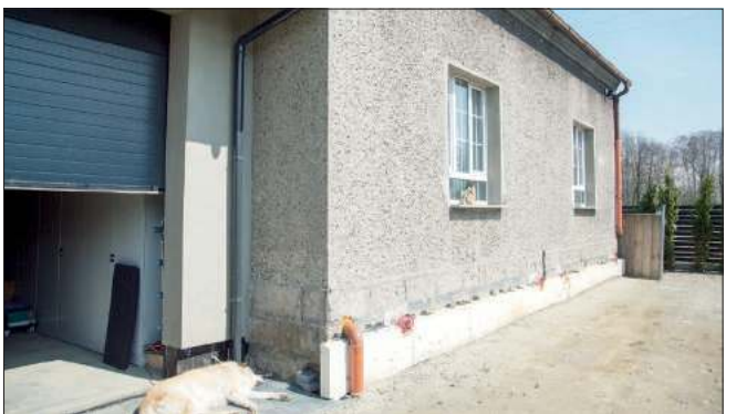
■ Ten niepozorny budynek miał służyć Grabowskim za pomieszczenie gospodarcze. Nie planowali tu większych inwestycji. Ostatecznie musieli się tu wprowadzić, co wiązało się z koniecznością wyremontowania instalacji wodno-kanalizacyjnej i elektrycznej, łazienki, kuchni, podłóg, a także osuszeniem piwnic, podwieszeniem sufitów, wymianą drzwi wejściowych, okien, pieca centralnego ogrzewania i kaloryferów.
