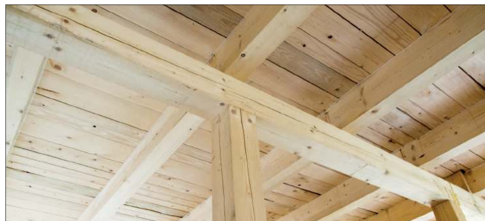
■ Na zdjęciu widać szare elementy drewniane. Oznacza to, że drewno zostało dotknięte tzw. sinizną, czyli grzybem. W ogóle drewno do budowy tego domu to osobna historia. Dostarczył je budowlaniec, informując, że na razie nie może go zafakturować, ale wystawił za nie pokwitowanie. Później miał twierdzić, że to Grabowski kupił drewno i on – wykonawca – nie ma wpływu na jego jakość.
