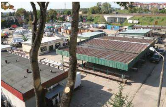
Remontowana jest wiat nr 2
