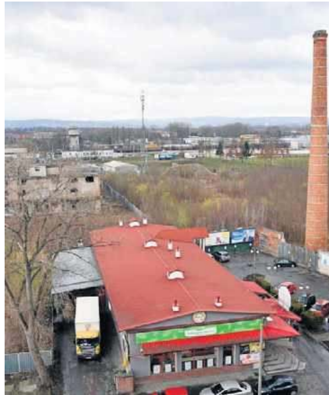
Na Owintarze dotąd nie widać ani śladu inwestycji, a w Tarnowie krążą pogłoski, że inwestor wycofał się
