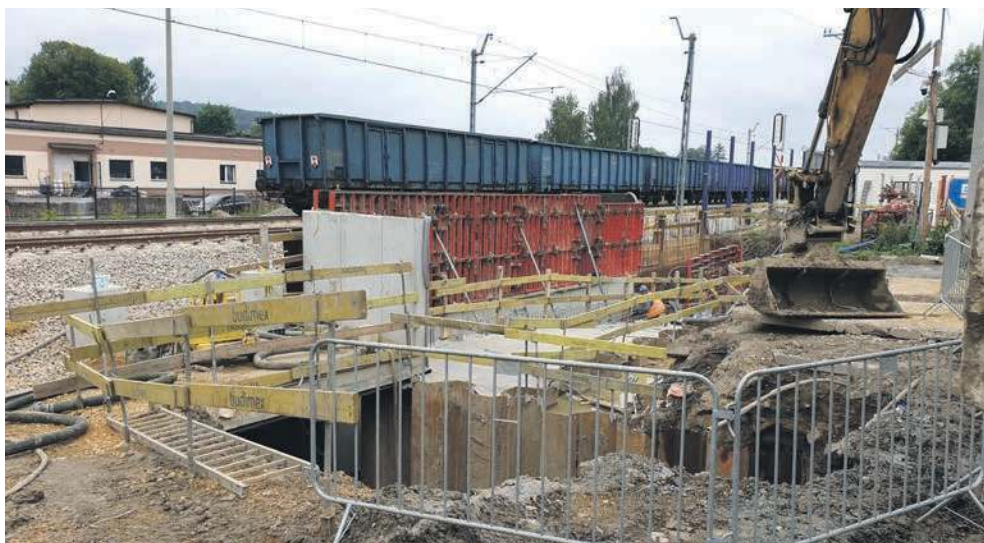
Rozkopany przejazd kolejowy na ul. Zagrody
