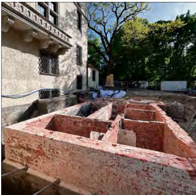
Odkryte pomieszczenia pełniły niegdyś funkcje magazynowe.
