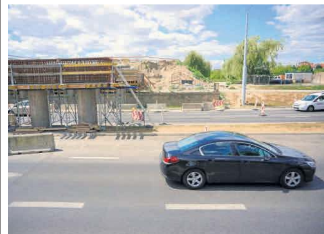
Kolejarze wracają do przerwanych w ubiegłym roku prac przy przebudowie wiaduktu kolejowego nad ul. Damentową
