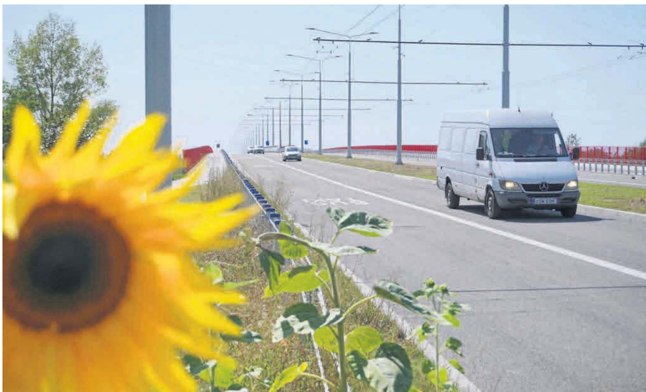
Ul. Grygowej. Kierowcy od poniedziałku mogą korzystać z drogi przebudowanej na odcinku od Pancerniaków do Metalurgicznej
