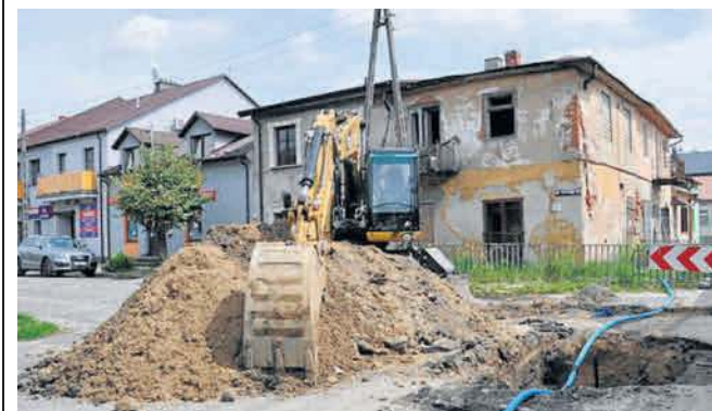
Prace prowadzi Przedsiębiorstwo Gospodarki Komunalnej i Mieszkaniowej „Łęczna” pod nadzorem archeologa
