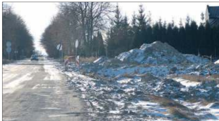
Prace przy budowie odcinka nowej S17 w okolicach Lubyczy Król. rozpoczęto jeszcze w zeszłym roku, mają potrwać do 2027 r.
