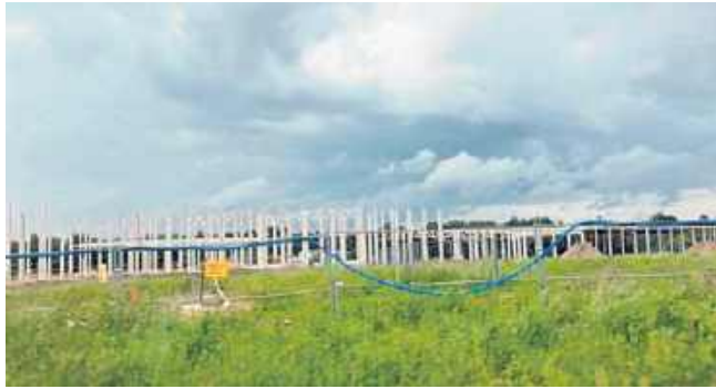
Na placu widać już konstrukcję przyszłego magazynu
