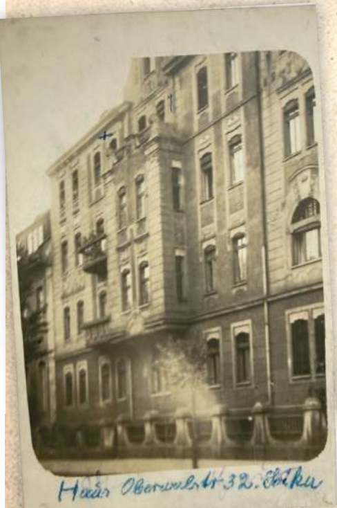
■ Kamienica przy Oberwallstraße 32, dzisiejszej ulicy Drzymały
