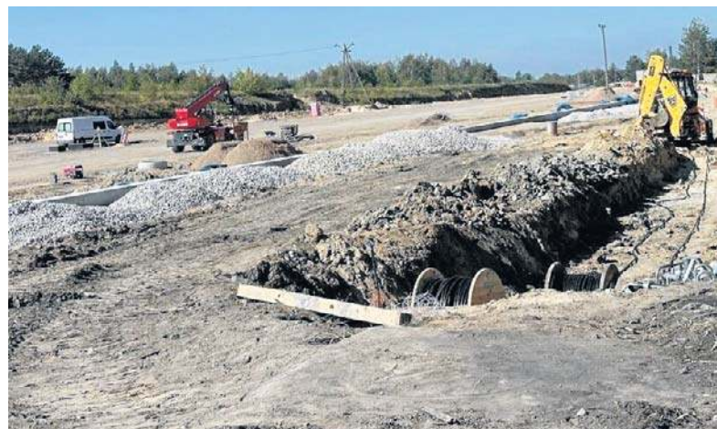
Przy ulicy Energetyków trwa budowa terminala przeładunkowego. Mieszkańcy obawiają się ciężarówek, hałasu i wzrostu ruchu.
