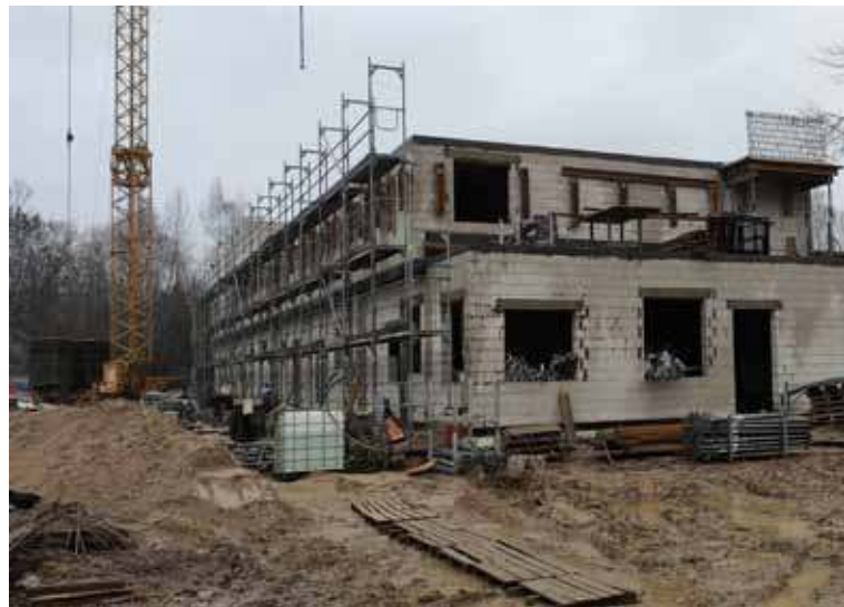
Trwa budowa budynku mieszkalno-usługowego przy ulicy Śniadeckiego 17
