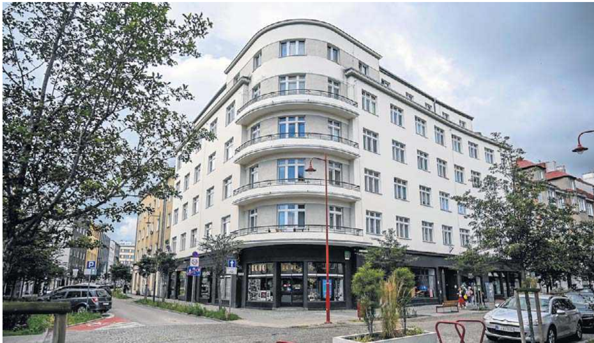
Kamienica Hundsdorffów przy ul. Starowiejskiej
