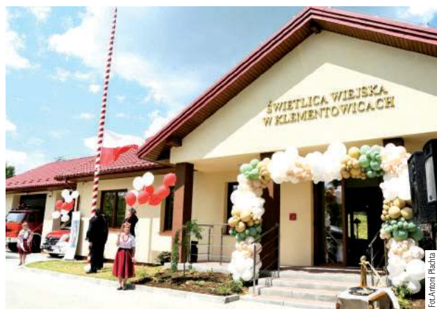
Budynek będzie pełnił nie tylko funkcję świetlicy wiejskiej. Swoje miejsce będą mieli tu także strażacy ochotnicy z miejscowej OSP
