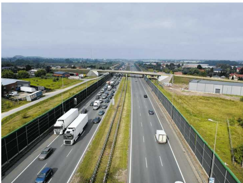
• Autostrada A2 na odcinku Warszawa – Łódź
