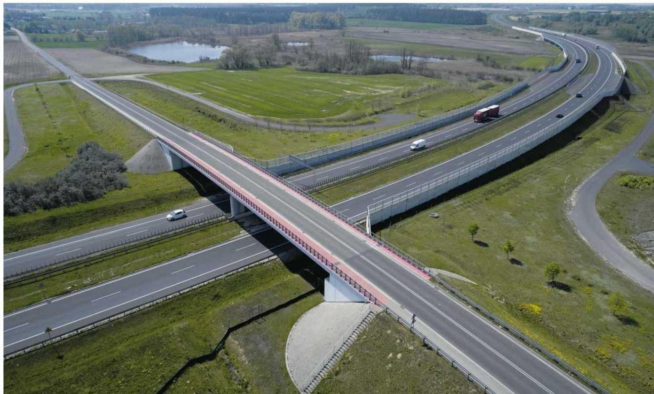
• Ruch na zachodniej obwodnicy Poznania jest tak wielki, że w 2025 roku przeszła pierwsze remonty zużytej już nawierzchni. Dziś trudno sobie wyobrazić aglomerację poznańską bez tego fragmentu S11. FOT. ŁUKASZ CYNALSKI / AGENCJA WYBORCZA.PL
