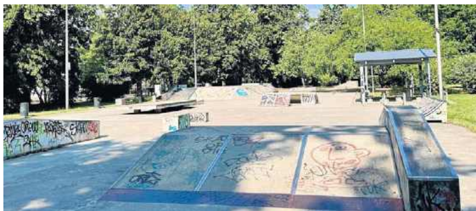
Tak wyglądał skatepark przed modernizacją.
