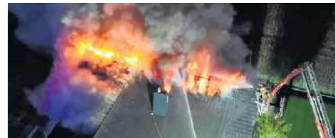
Gwałtowny pożar poddasza domu w Zielonej Łące.
