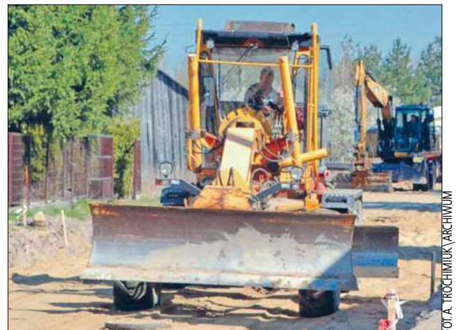
W poniedziałek opublikowano listy inwestycji drogowych dofinansowanych przez państwo. Skorzysta powiat radzyński i gmina Kąkolewnica
