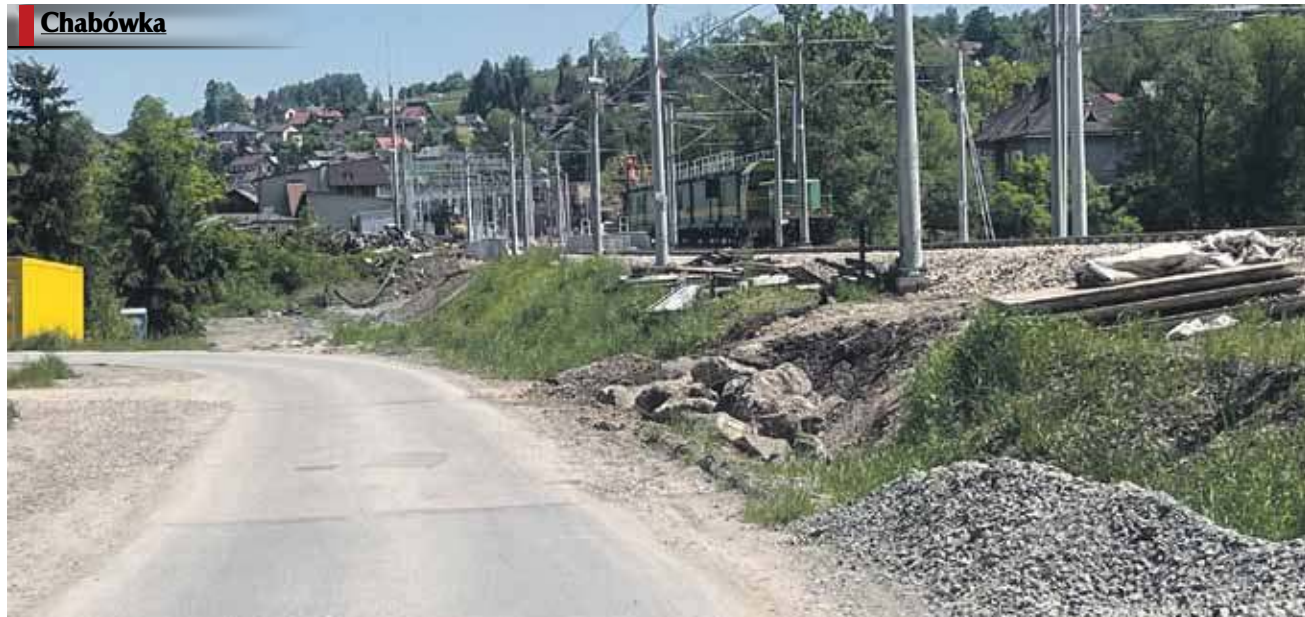
Ciężki sprzęt, pracujący przy modernizacji linii kolejowej, rozjeżdża lokalne drogi w Chabówce.
