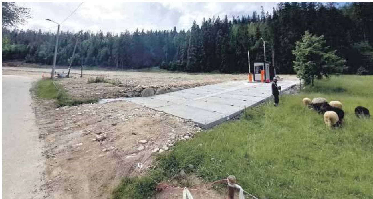
Ogromny parking niemal gotowy. Brakuje jednak pozwolenia budowlanego.
