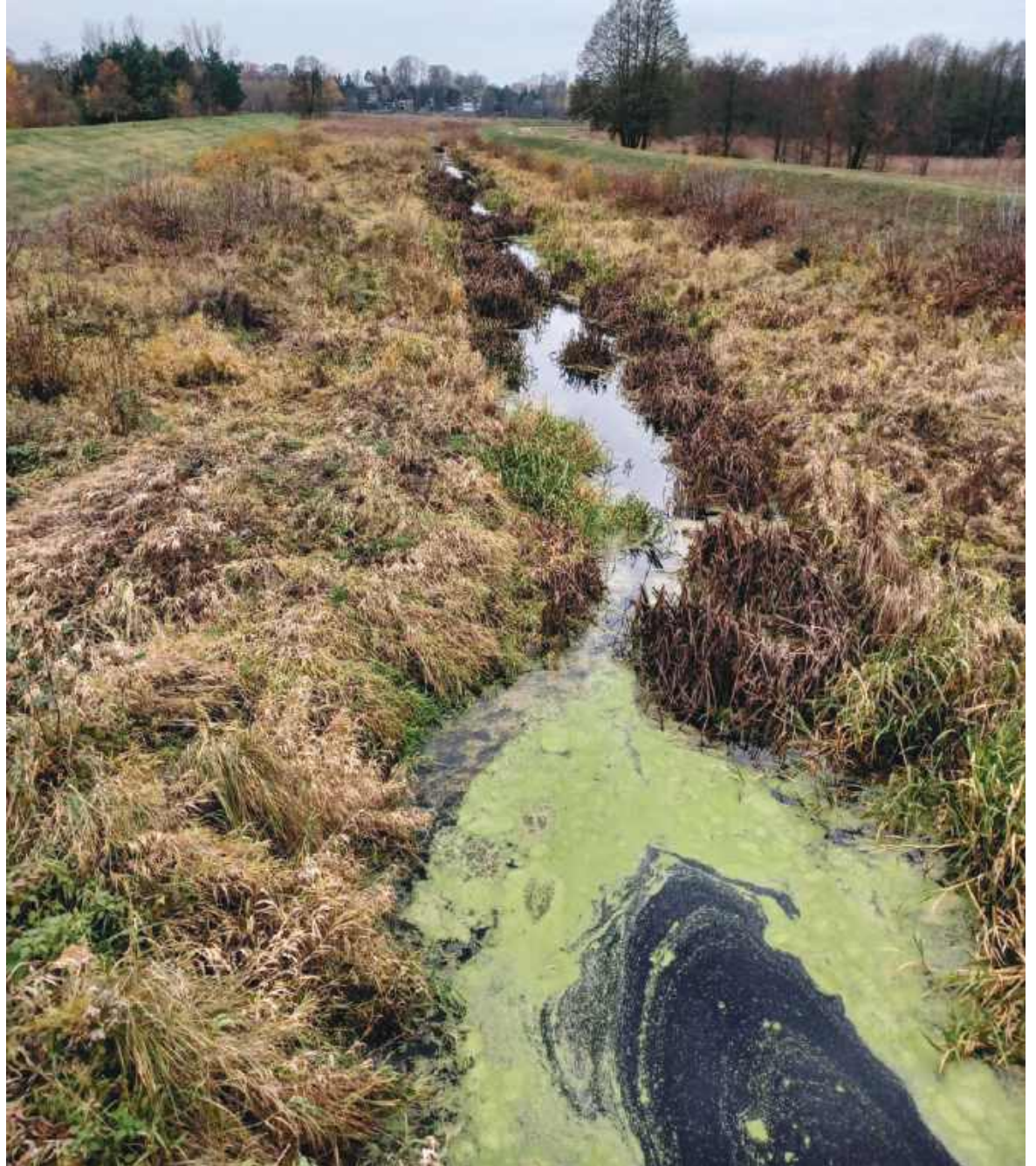
Prut przed rewitalizacją
