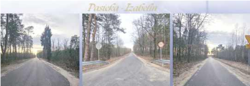
Fot. Gmina Sosnowica
