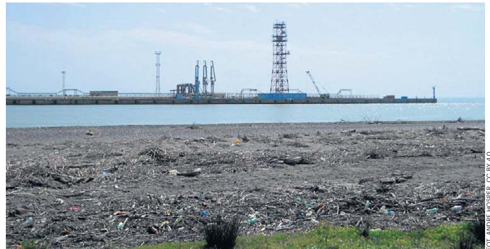
Nowa gruzińska rafineria Kulevi przyjmuje ropę z Rosji. Zakład nad Morzem Czarnym rozpoczął działalność w październiku
