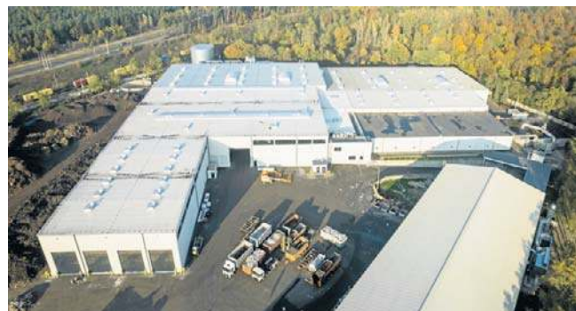
Prace przy nowej hali Remondisu przy ulicy Inwalidów zakończono jesienią 2024 roku
