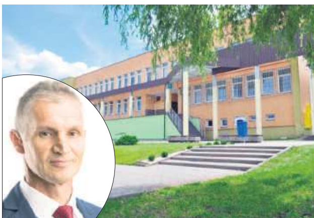
Stanisław Dyjak: W ostatnich latach udało się nam spłacić 3,5 mln zł długu, który zastałem, gdy obejmowałem urząd i na koniec zeszłego roku mieliśmy zerowy poziom zadłużenia.
