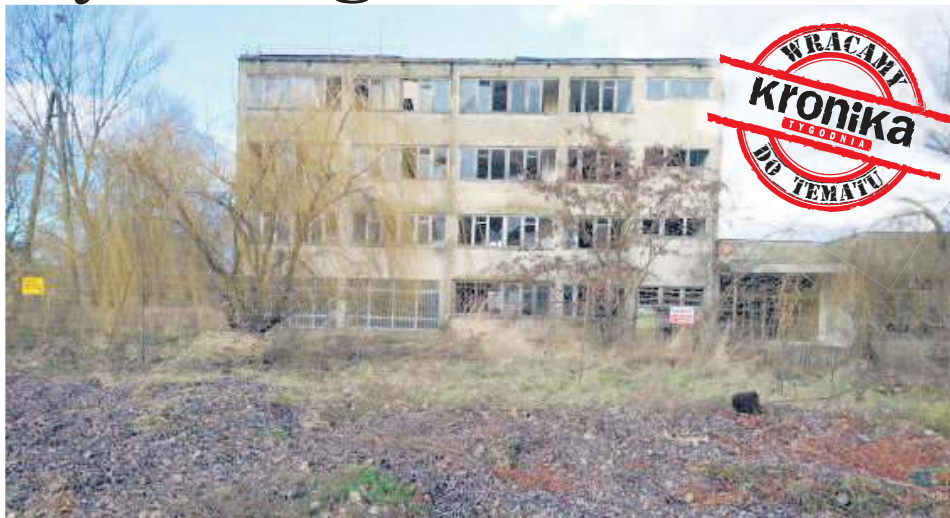
Właściciel zabezpieczył kratami wejścia do zdewastowanego budynku, a teren wokół niego ogrodził siatką i oznaczył tablicami ostrzegawczymi.
