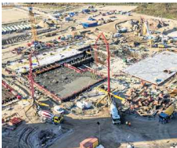
Prace fundamentowe na budowie elektrowni w Gdańsku
