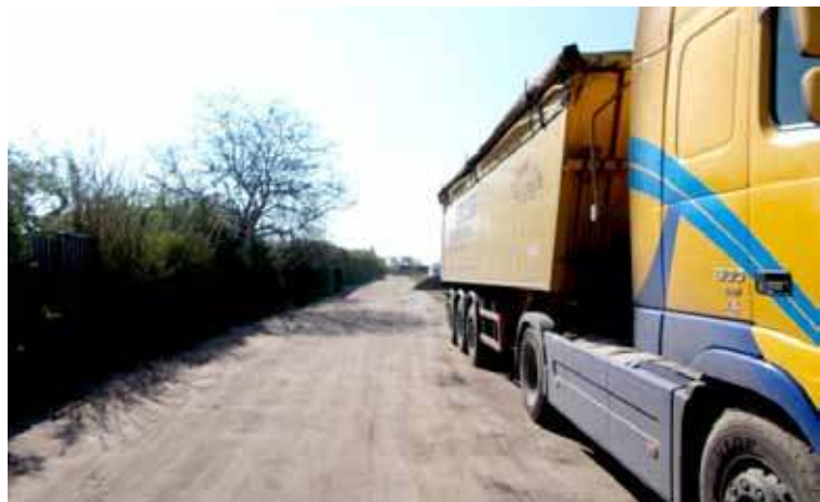
Łącznik ul. Spokojnej i Broniewskiego w czasie remontu
