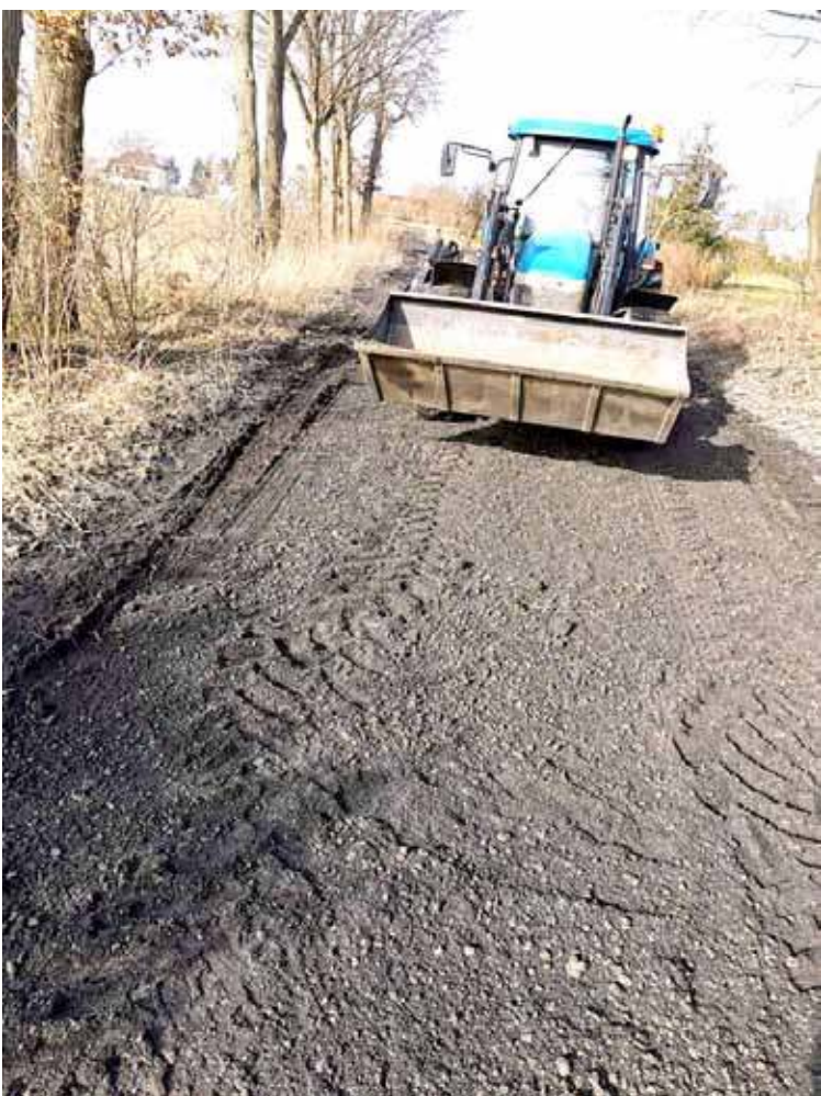
Pracownicy Spółdzielni Pod Dębami wykonywali prace naprawcze na alternatywnej drodze w Starej Dąbrowie
