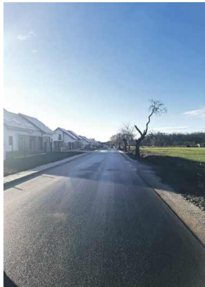
Zrealizowana inwestycja drogowa w Wiszni Małej ul. Szkolna
