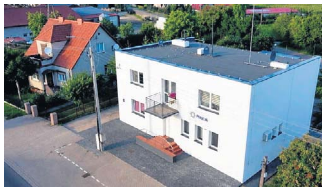
Modernizacja budynku komunalnego w Damasławku.
