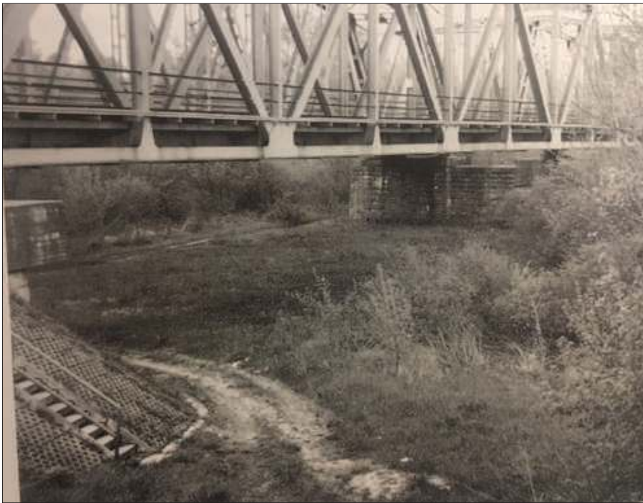
■ Miejsce kaźni Żydów, znajdujące się obok mostu kolejowego na rzece Wieprz. Część Żydów zamordowano i wrzucono do rzeki, innych wrzucono do dołu, który sami wykopali
