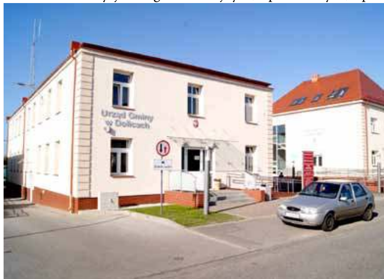
Remont przeszły budynki Urzędu Gminy w Dolicach
