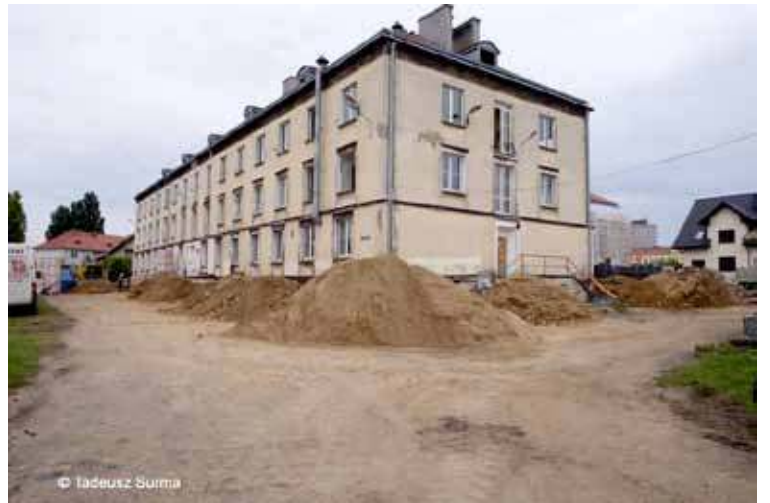
Prace remontowe prowadzone w Bursie Szkolnej pochłonęły największe środki
