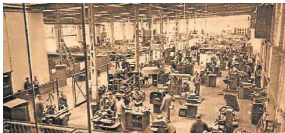
Lipiec 1948 r., hala produkcji wagonów kolejowych w Pafawagu
