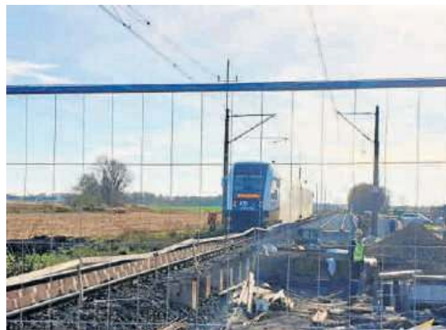
Przystanek Iwiny będzie gotowy w połowie 2021 roku. Koszt budowy wynosi 8,8 mln zł netto
