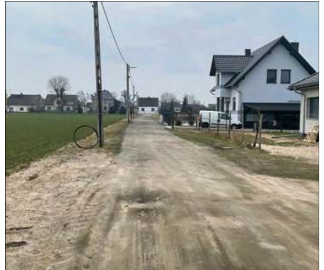
Odcinek ulicy Mickiewicza w Steblowie zostanie przebudowany.
