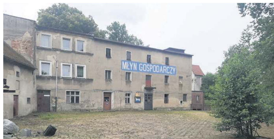
Remont tego budynku pochłonie od półtora do dwóch milionów złotych. Obecnie w środku i na zewnątrz trwają prace porządkowe
