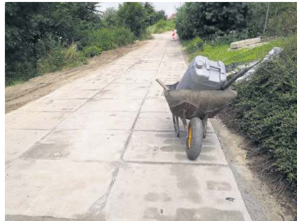
Zniszczony fragment ul. Tęczowej utwardzony został ciężkimi betonowymi płytami, a cały ponad 3 metrowy pas został odpowiednio wyprofilowany
