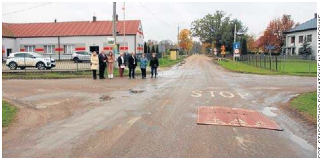
Mieszkańcy gminy Szumowo w końcu doczekają się budowy ronda na skrzyżowaniu w Pęchratce Polskiej
