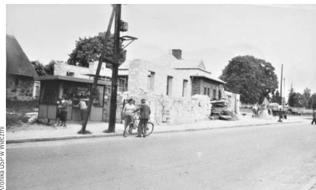
Rozbudowa remizy w Wieczfni, w latach 1988-1989.
