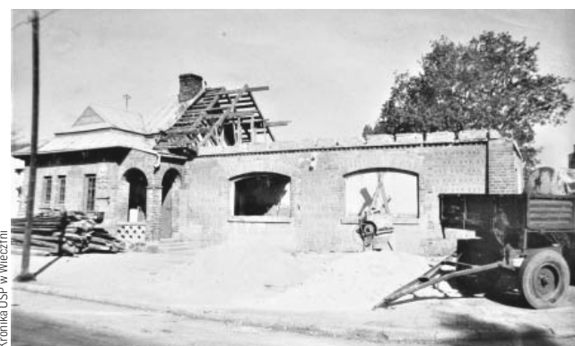
Rozbudowa remizy w Wieczfni, w latach 1988-1989.
