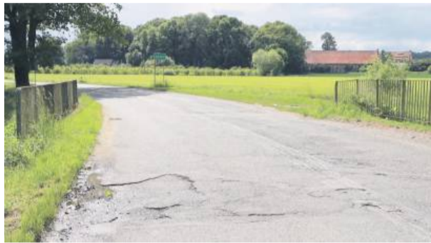
Pierwszy etap przebudowy będzie obejmował odcinek od skrzyżowania w Sarbach do Wigańcic
