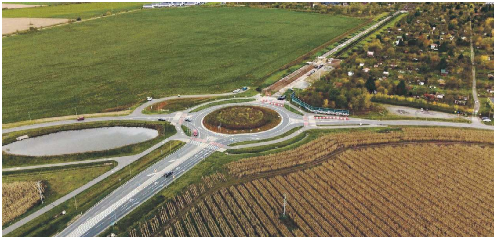
Ostatni odcinek obwodnicy domknie ring obwodnicowy wokół stolicy Dolnego Śląska
