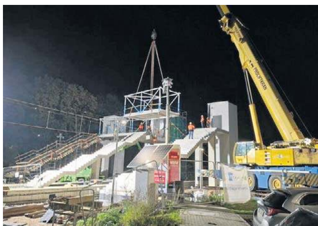
Kładka łączy trzy szyby windowe, umożliwi też dojście do parku przy ulicy Hożej
