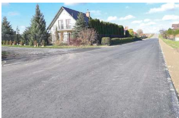
Od teraz mieszkańcy ul. Podgórnej w Klikawie mogą jechać komfortowo. Droga zyskała nową nawierzchnię
