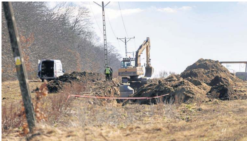
Prace przy uzbrajaniu strefy przemysłowej w Słupsku. Teren jest położony po zachodniej stronie miasta
