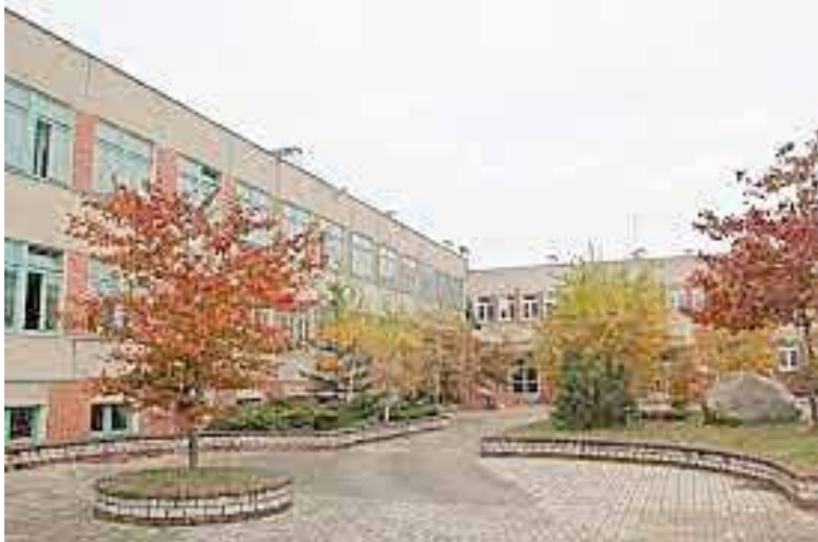
W czerwcu poznamy wyniki przetargu na termomodernizację m.in. budynku II LO
