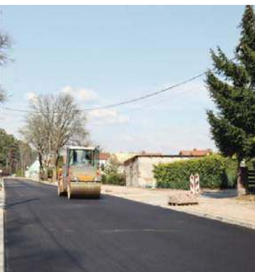
Modernizacja ul. 1-go Maja w Gołdapi
