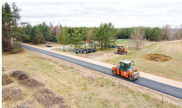
Z udziałem środków z Polskiego Ładu realizowana jest m.in. przebudowa drogi gminnej Kazanice-Rodzone
