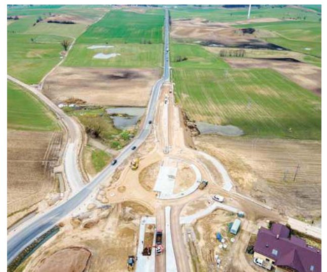
Prace przy budowie ronda na drodze krajowej nr 15
