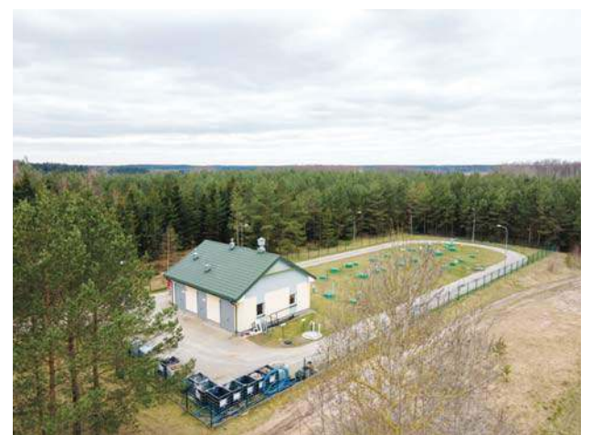
Rozbudowa oczyszczalni – zadanie o wartości prawie 7 mln zł otrzymało 4 mln 655 tys. zł dofinansowania z Rządowego Funduszu Polski Ład
