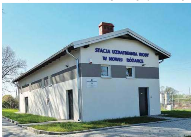
Stacja uzdatniania wody w Nowej Różance
