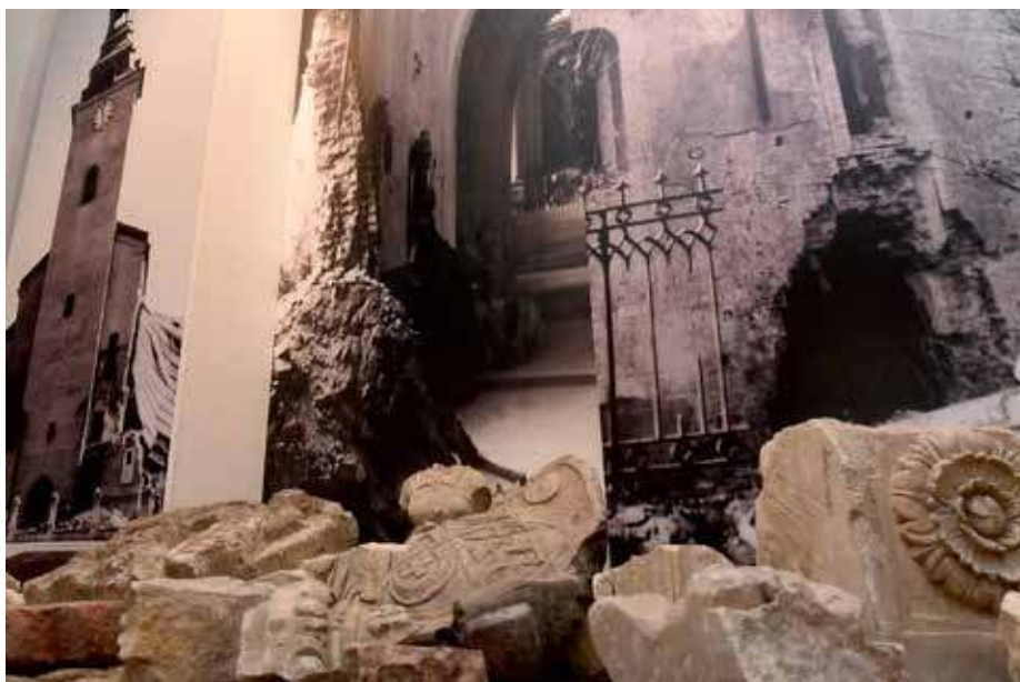
Niemcy na pewno widzieli, co bombardują. Zrzucone kilku bomb na zabytkowy gmach kościoła farnego pw. Michała Archanioła z wysoką na ponad 30 metrów wieżą nie mogło być nieświadome Fot. Mirosław Grabczak, Muzeum Ziemi Wieluńskiej, opr. red.
