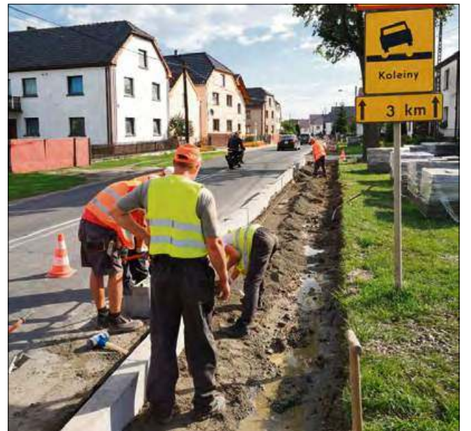
Robotnicy uwijają się przy remoncie chodnika wzdłuż drogi wojewódzkiej nr 409 w Kujawach.
