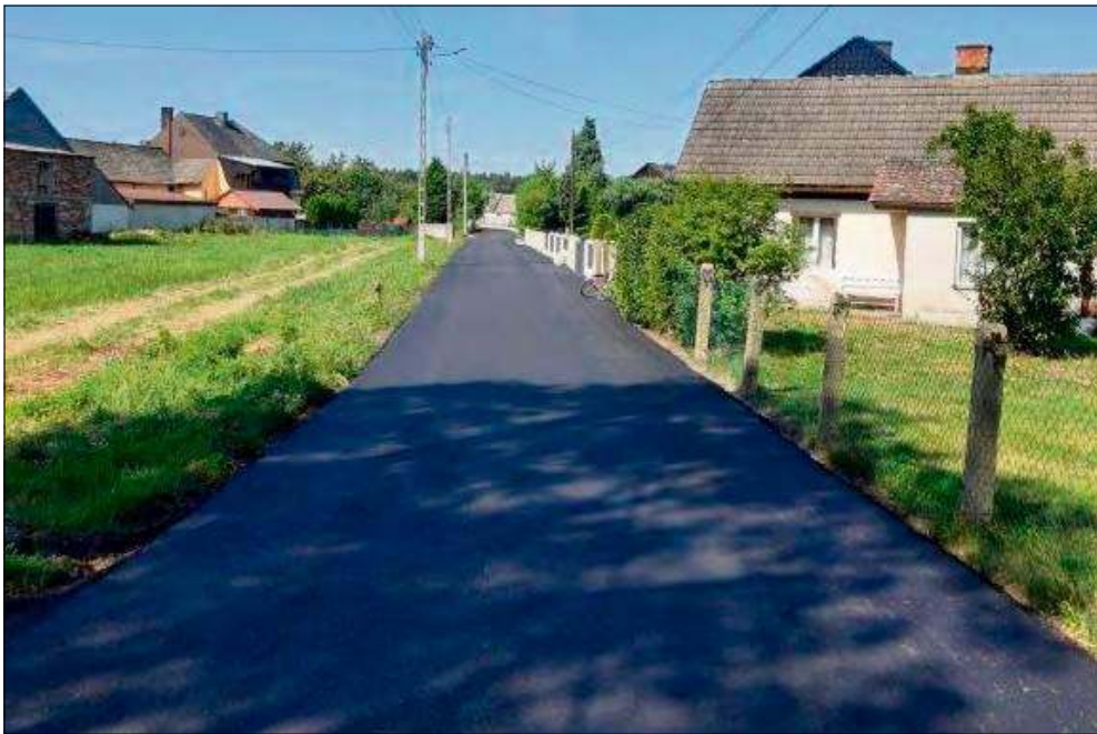
Stan drogi jakim cieszą się aktualnie mieszkańcy przy ul. Pachów w Smolarni.
