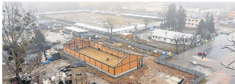
Przy ul. Gnieźnieńskiej w Wągrowcu, w rejonie placu targowego, trwa budowa nowego obiektu handlowego, w którym mieścić się będzie market sieci Dino.
