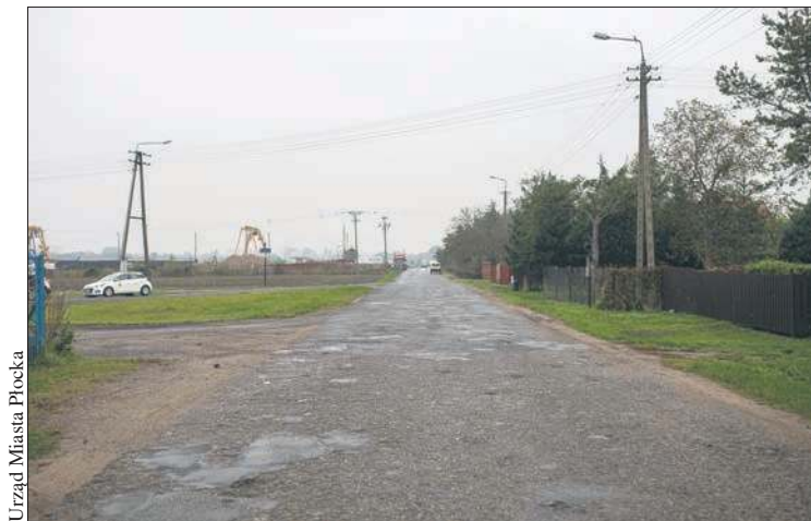
Roboty drogowe zostały zaplanowane między innymi na ul. Boryszewskiej
