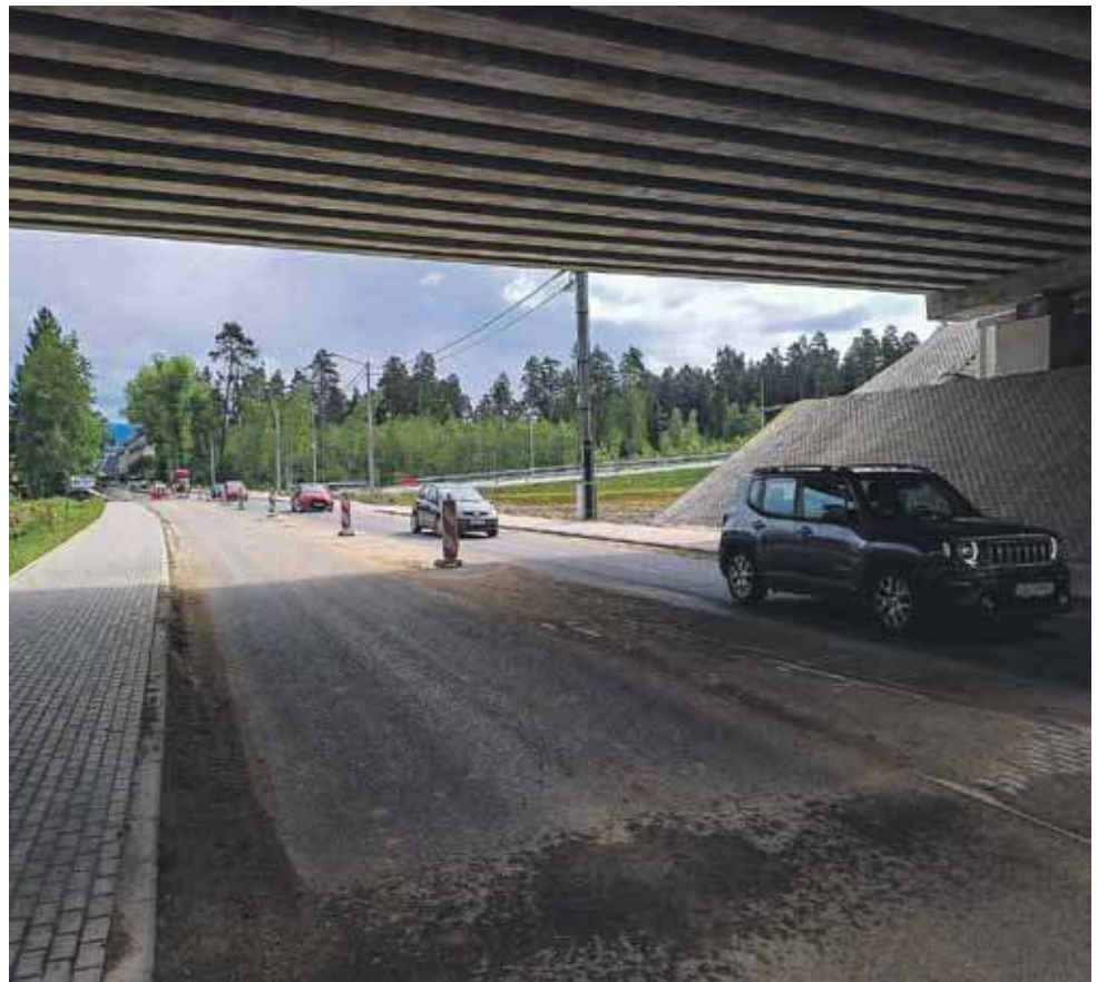
Przejazd pod wiaduktem węzła Nowy Targ Zachód odbywa się tylko jednym pasem.
