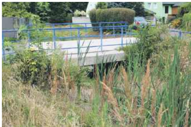
Potok Nieszkowicki w Kazanowie ma zostać udrożniony
