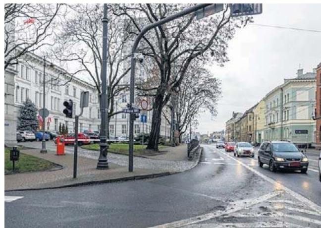
Wjazd w ulicę 19 Marca 1981 r. z przejściem dla pieszych nie będzie na razie doświetlony
