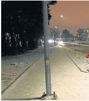
Latarnia stoi, ale ma zostać przesunięta
