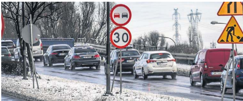
Prace naprawcze w latach 2020-2022. wydłużyły żywotność wiaduktów o 10 lat
