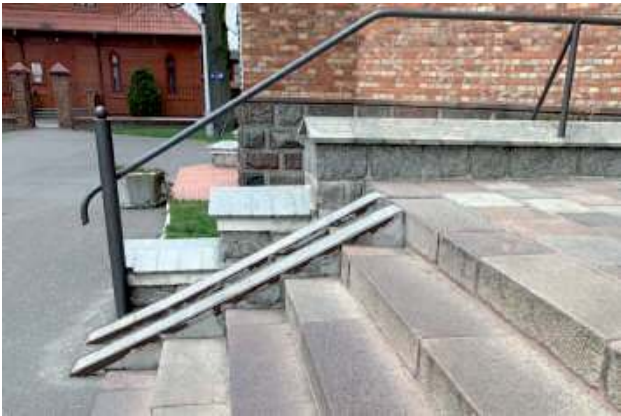
Tak obecnie wygląda podjazd. Zdaniem naszej Czytelniczki, nie spełnia żadnych norm i nie da się tędy wjechać na wózku inwalidzkim
