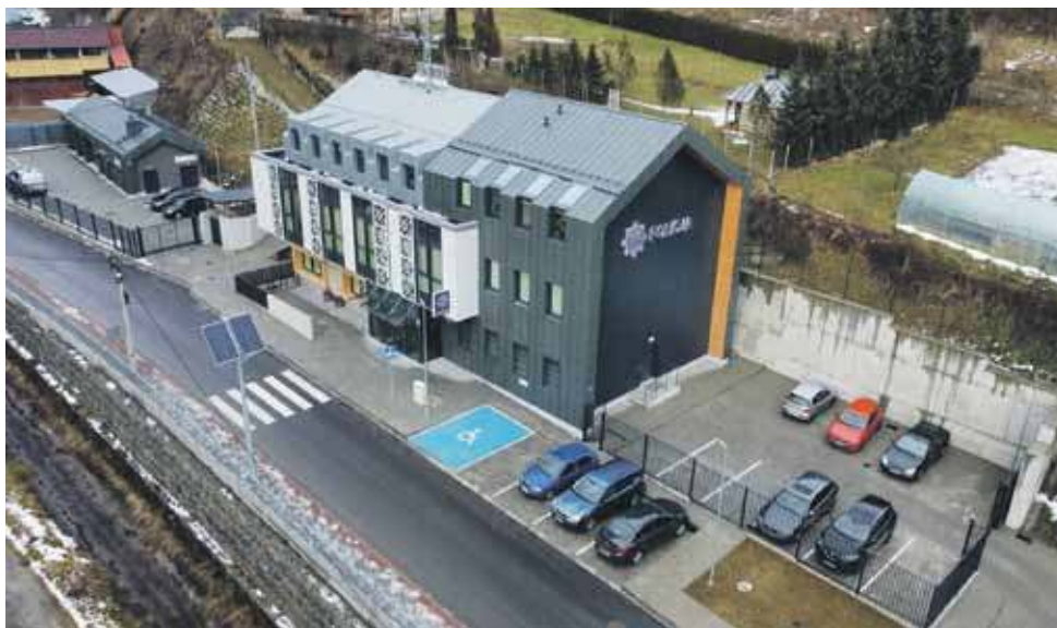
Komisariat policji w Szczawnicy jest nowoczesnym obiektem.
