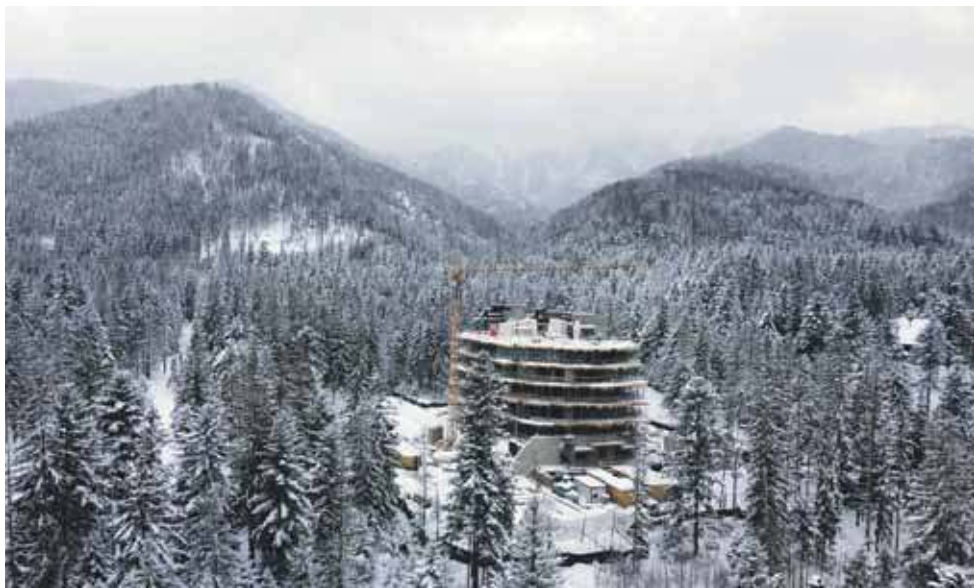
Tak budowa u wylotu Doliny Białego wyglądała we wtorek.
