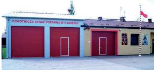
Nowy dwustanowiskowy garaż na wozu OSP w Kamieniu
