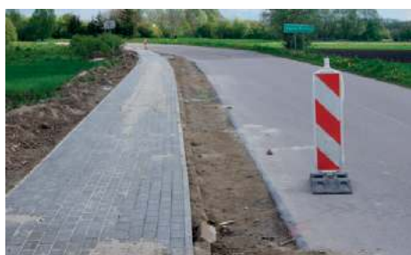
Modernizacja drogi w Kamieniu Kolonii
